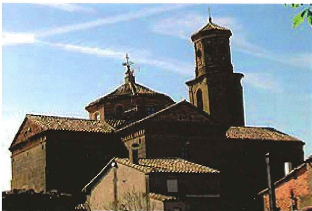
Iglesia parroquial con la torre inclinada
