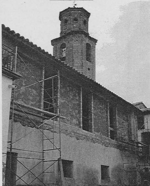
Ayuntamiento de Casbas en restauración. "Casa d'o Lugar"
