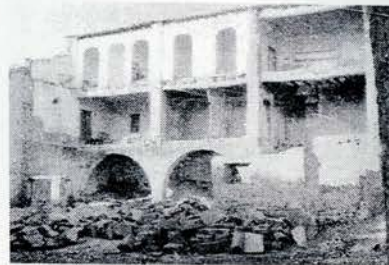
Obras en el Ayuntamiento antiguo
