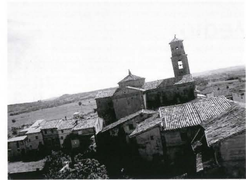
Vista lateral de la iglesia de San Nicolás
